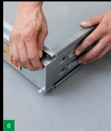
3 Vložte koľajnicu s nadpražím do hornej časti puzdra
