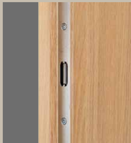
Dodatočné spodné blokovanie pri voliteľnom bezpečnostnom vybavení RC 2
